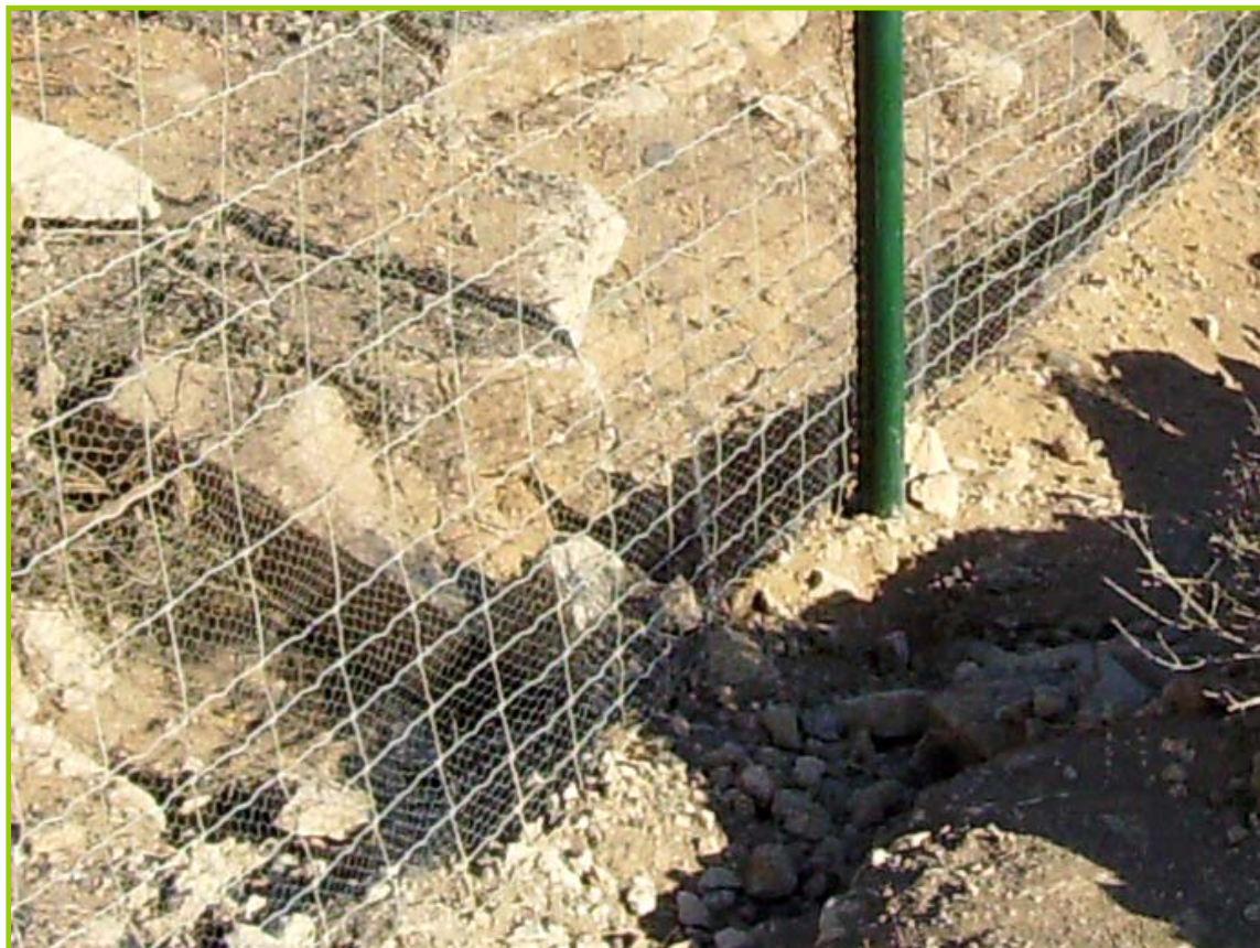
Detalle del doble mallado en el primer metro de la valla
