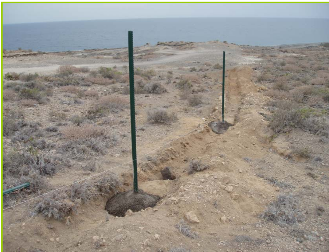
Colocación y hormigonado de postes para anclaje de la malla
