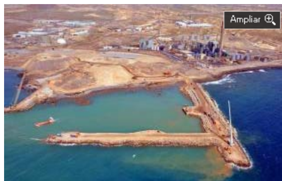
Obras para la construcción del futuro muelle de Granadilla de Abona. lot
