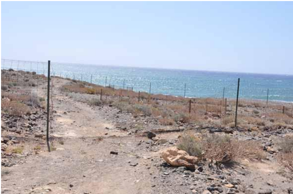
Figura 7. Aspecto de la valla periférica rota, facilitando el acceso libre.
