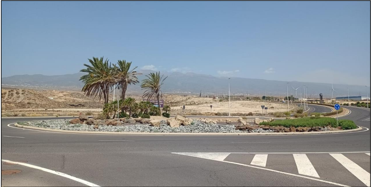
Figura 20 Rotonda del polígono industrial con uso de los bolos según condicionante ambiental.
