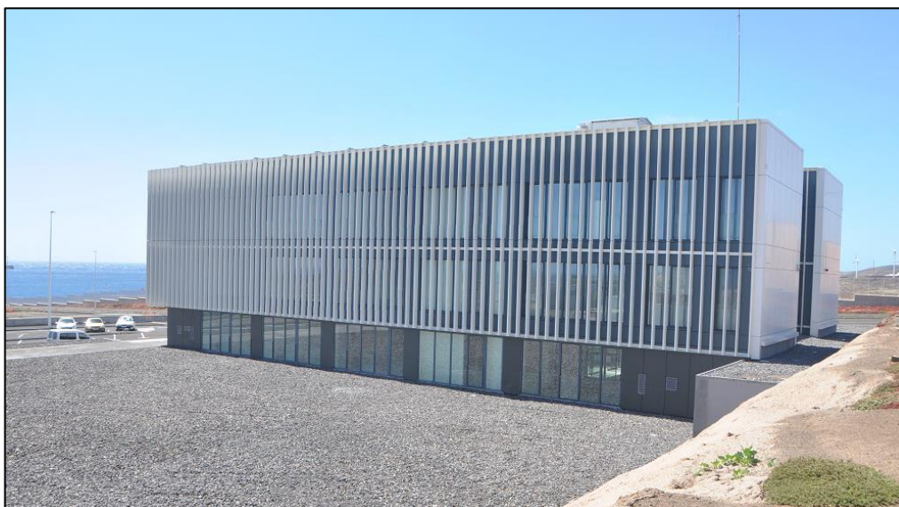
Figura 6 Edificio de servicios del puerto de Granadilla
