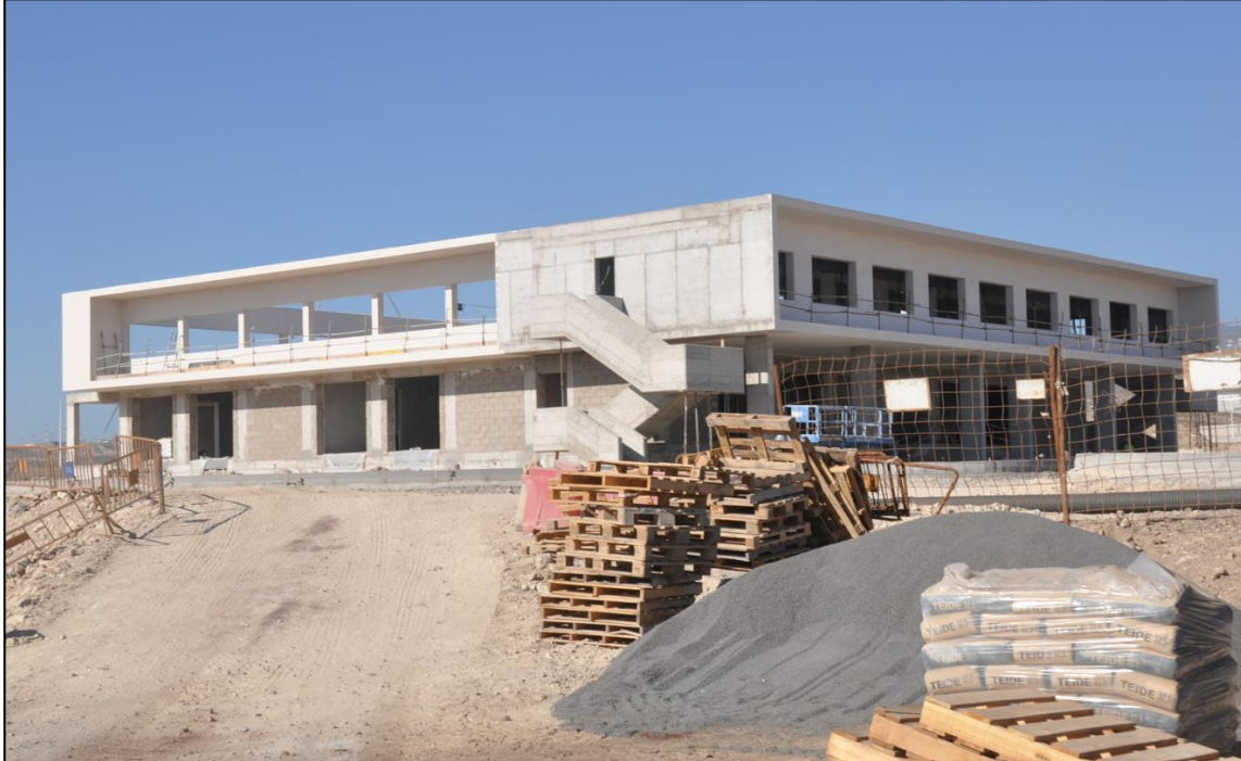
Figura 3 Centro de Inspección Portuario del puerto de Granadilla en construcción (12/01/2022)
