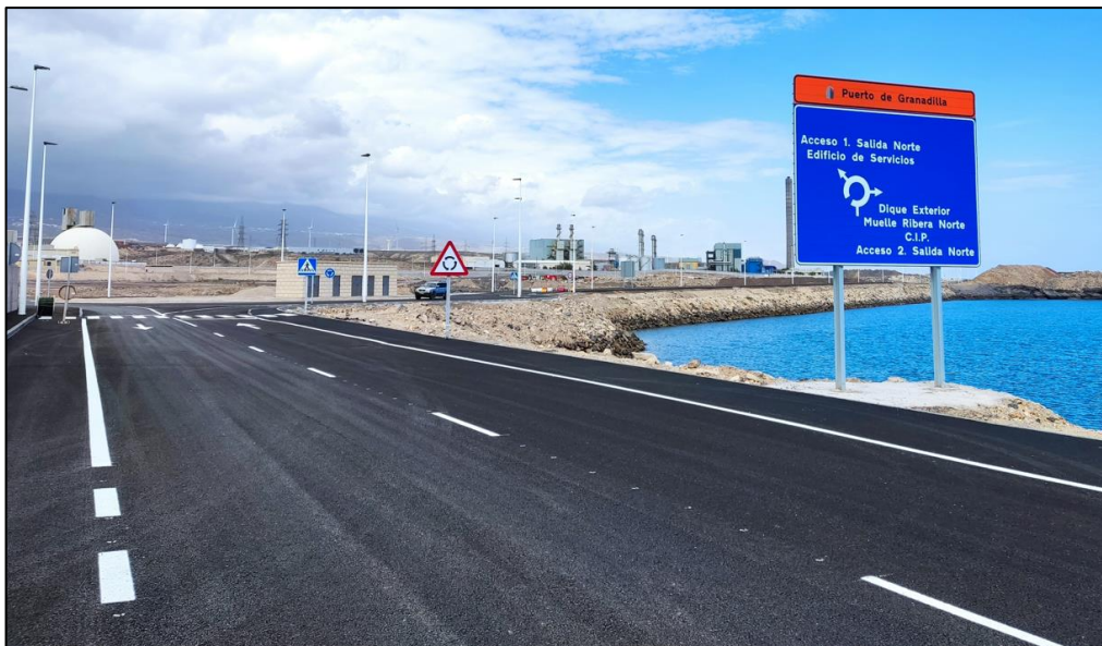
Figura 5 Viario en contradique del puerto de Granadilla
