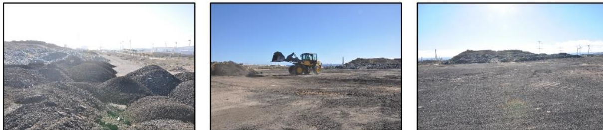
Figura 22 Evolución de los acopios de residuos asfálticos en la parcela de los acopios de callaos, hasta su retirada final. Izquierda: 12/01/2022. Centro: inicio de la limpieza (1/12/2022). Derecha: parcela ya limpia (13/12/2022)
