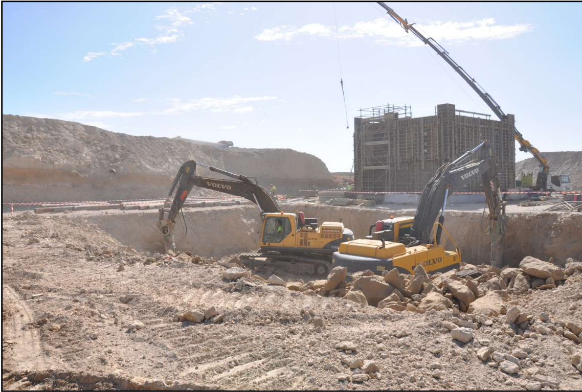
Figura 2: palas trabajando en la obra. Fecha 25/08/2022
