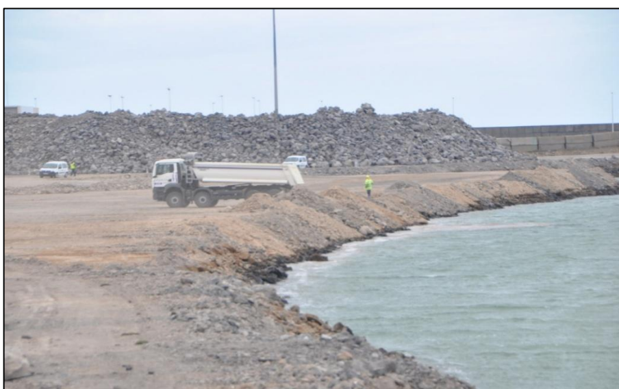
Figura 1: Relleno de la explanada (15-05-2024)
