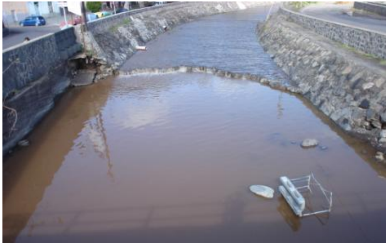
Figura 11 Cauce del barranco de El Cercado en a su desembocadura (febrero 2010)
