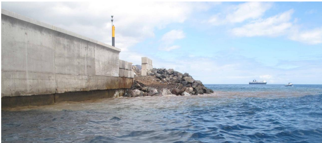
Figura 8. Presencia de turbidez en el agua con motivo de las obras
