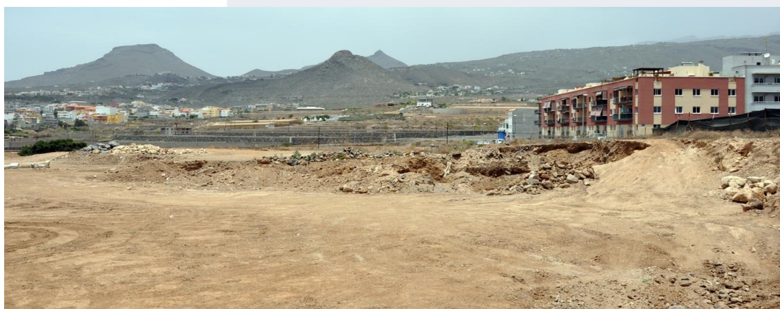
Estado final de la finca
