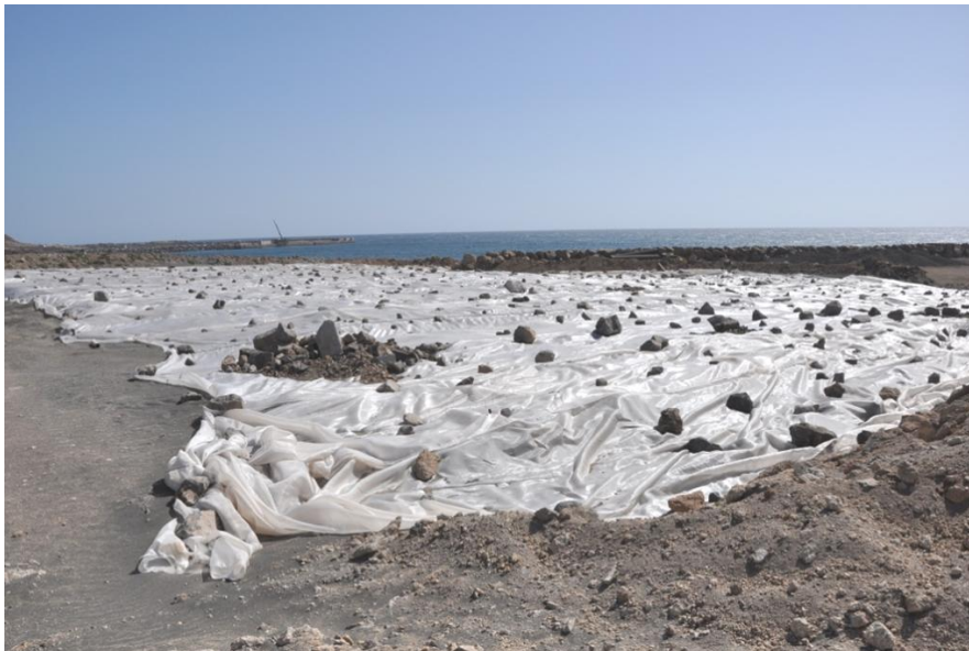
Figura 2. Acopio provisional de arena (cubierta con lona) en la zona de obras (14-2-2013)
