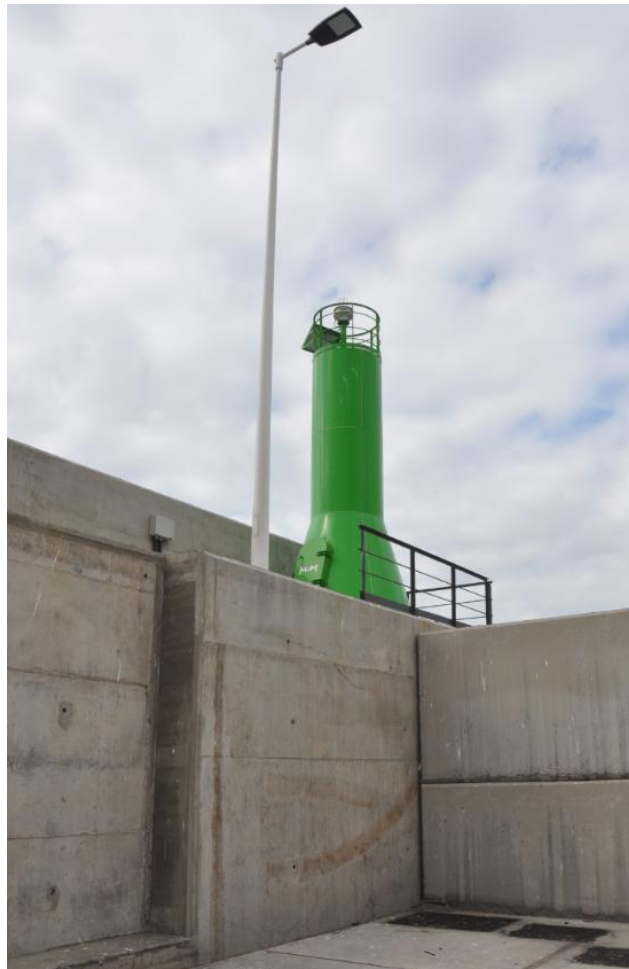
Figura 18. Luminaria definitiva instalada junto a marca de estribor de bocana (obra de abrigo)
