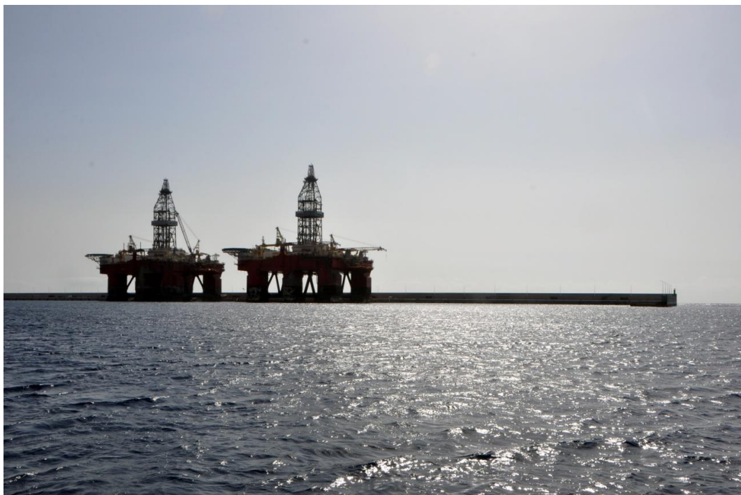
Figura 1. Obra de abrigo con plataformas atracadas (Fuente OAG)
