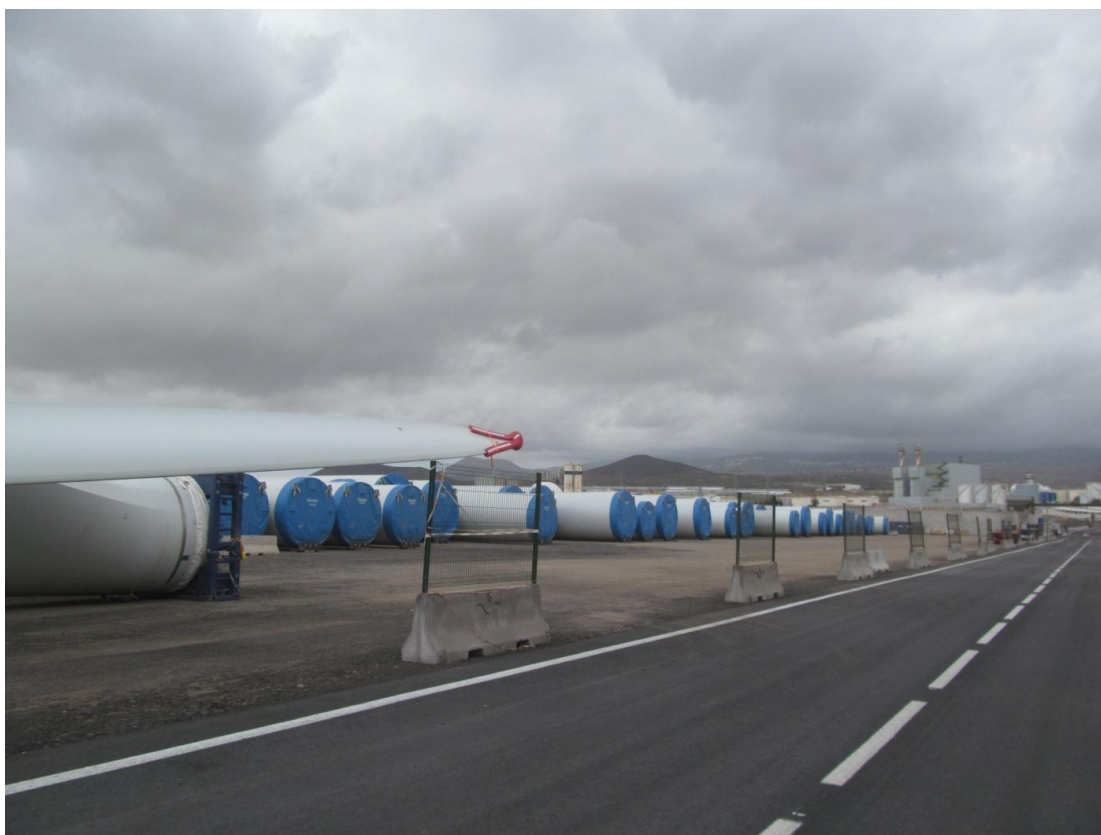
Figura 4. Descarga, almacenamiento provisional y distribución de partes de los aerogeneradores del parque eólico próximo (22 mayo 2018)
