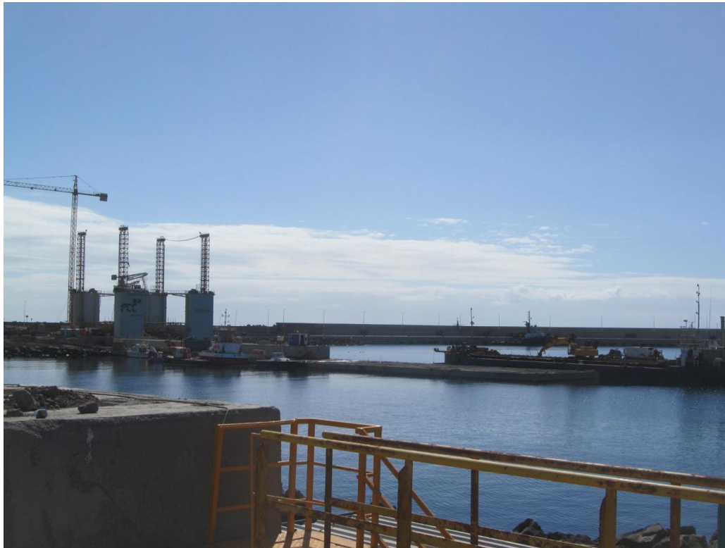
Figura 3. Trabajos en el segundo tramo del muelle de ribera (24 mayo 2018)
