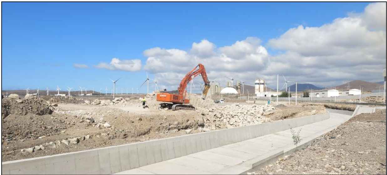
Figura 2. Parte de la canalización de pluviales perimetral (8 de mayo de 2020)
