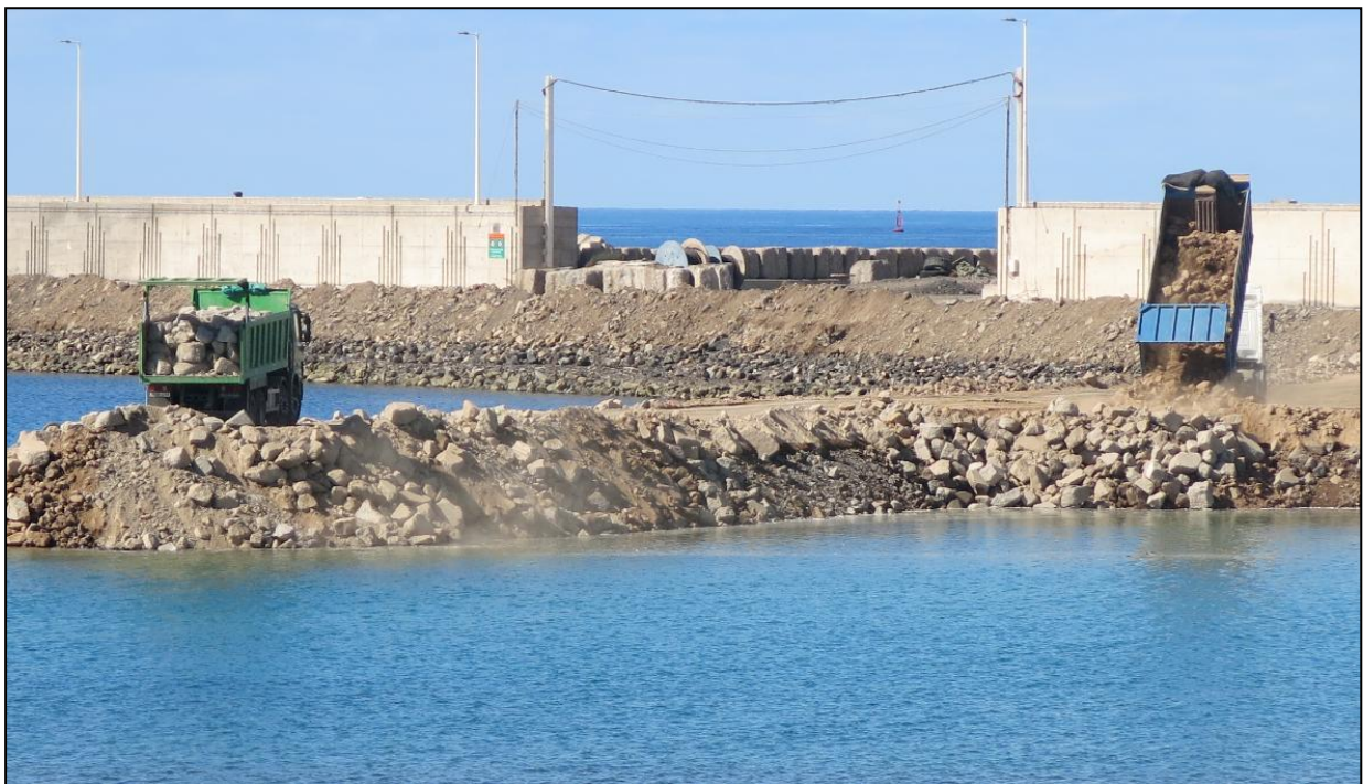
Figura 4. Comienzo del relleno del viario básico del puerto. Al fondo, el cargadero del contradique
