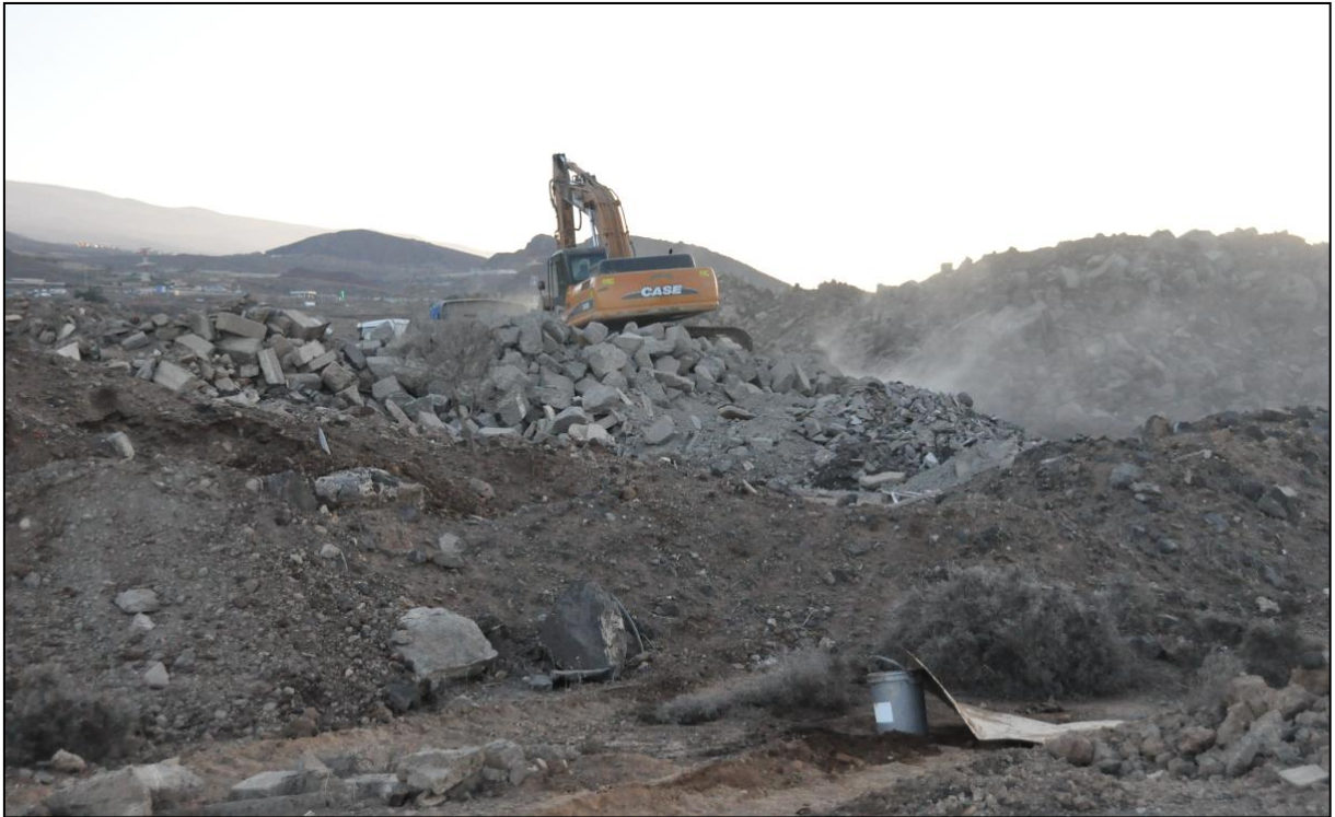
Figura 1: pala trabajando en los acopios del aeropuerto. Fecha 19/05/2020
