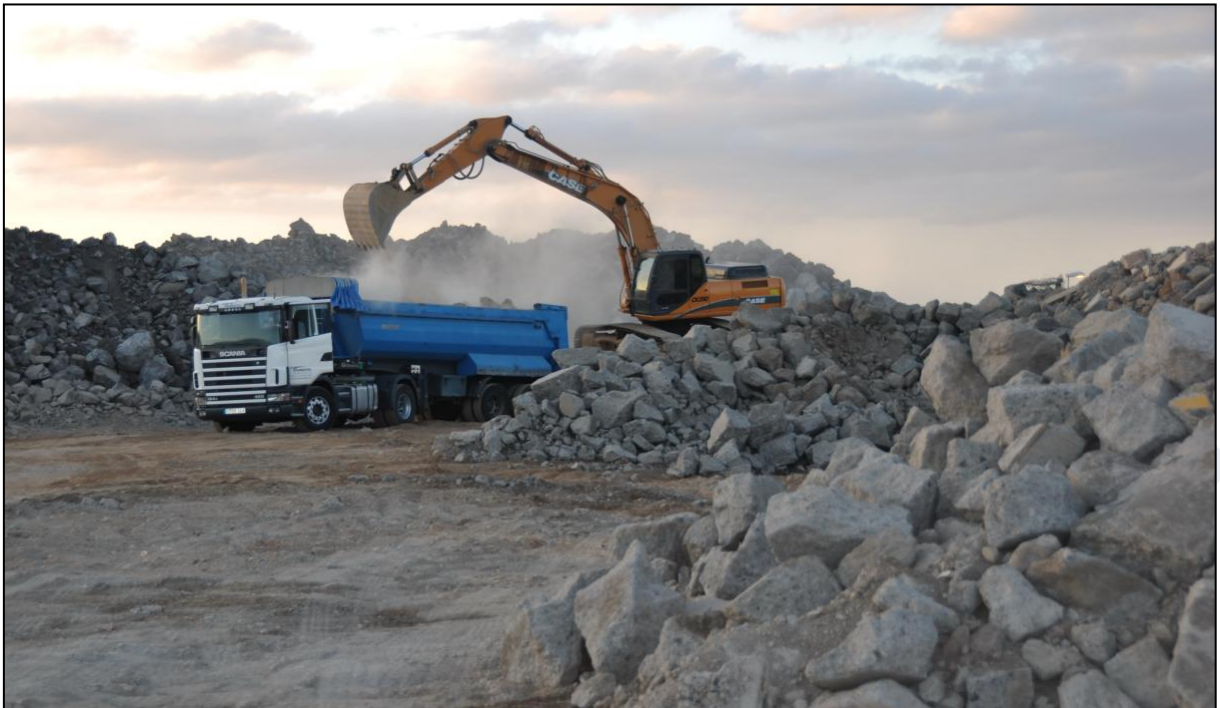
Figura 2: camión y pala trabajando en los acopios del aeropuerto. Fecha 19/05/2020
