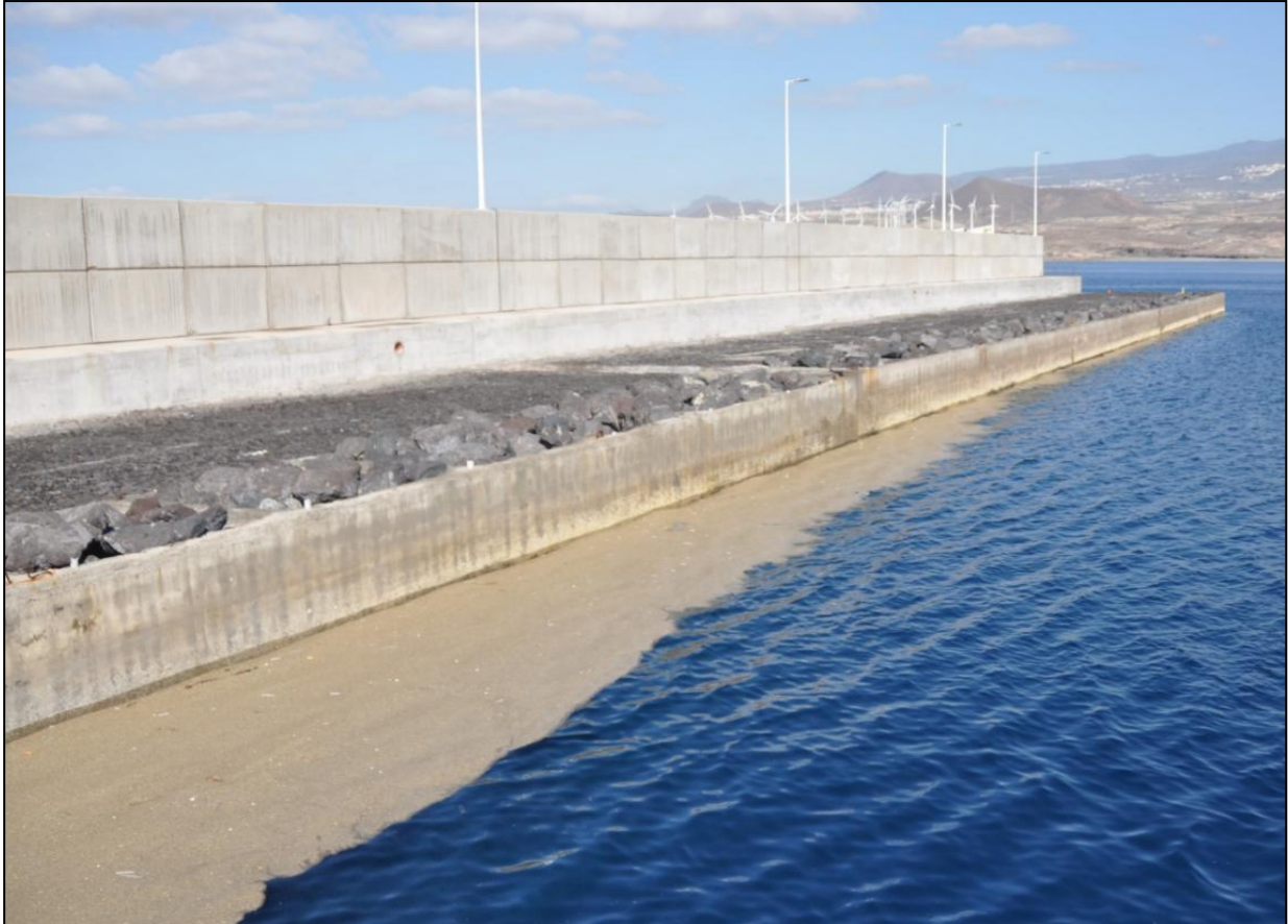
Figura 18. Acumulación en el contradique de pumitas (piedra pómez) tras los vertidos (con vientos del Noreste)
