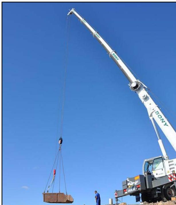
**Figura 18. Grúa basculante con cubeta de vertido.**
