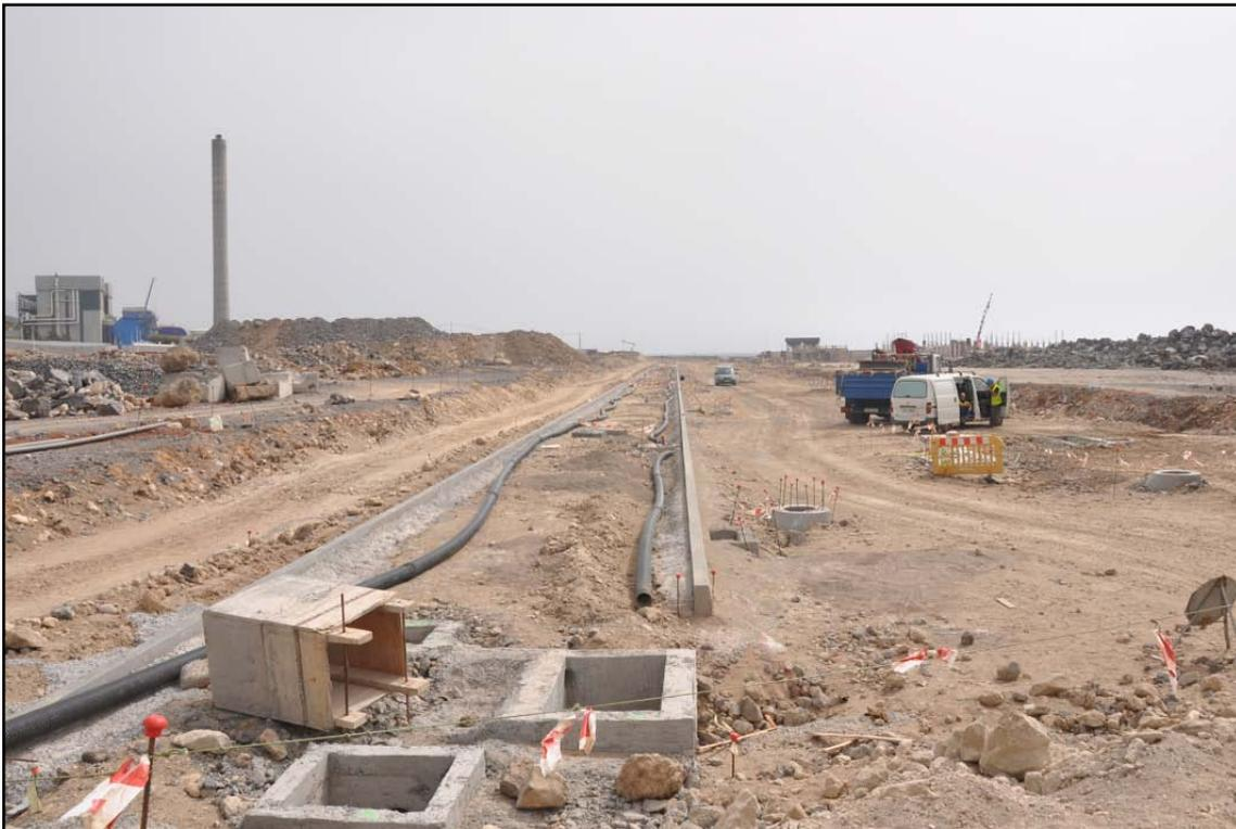
**Figura 10. Viario y redes básicas del puerto de Granadilla. Detalle de la rotonda del contradique hacia el cargadero de arena (20/05/2021).**
