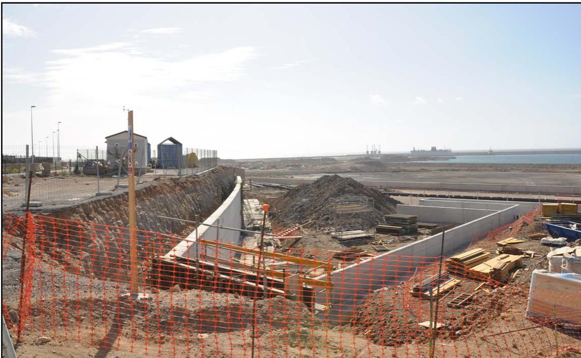
Figura 14. Muros de contención del talud del edificio portuario (24/05/2021).
