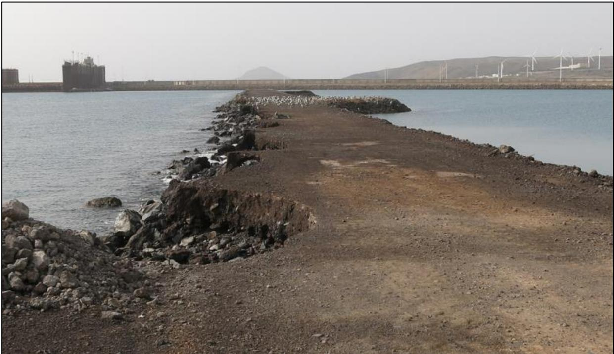
**Figura 2 Erosión por oleaje en la mota de cierre perimetral (19/01/2022)**
