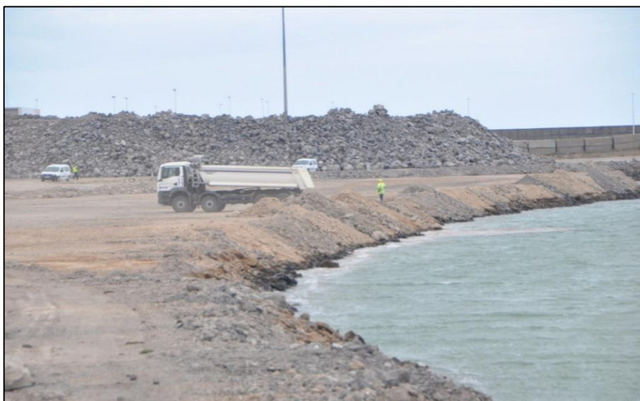
Figura 1: Relleno de la explanada (15-05-2024)
