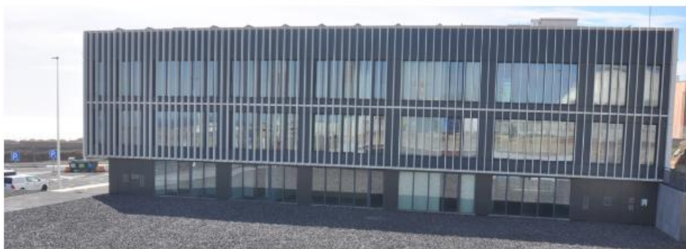
En 2023 es entregado el edificio de usos portuarios, con fachada en colores de la gama del ocre y de tierra.
