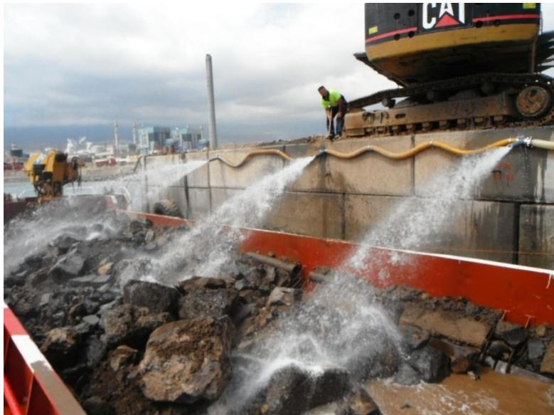
Figura 107. Ensayos de lavado realizados por la ute SATO-FCC-PPL (Foto A. Hernández)
