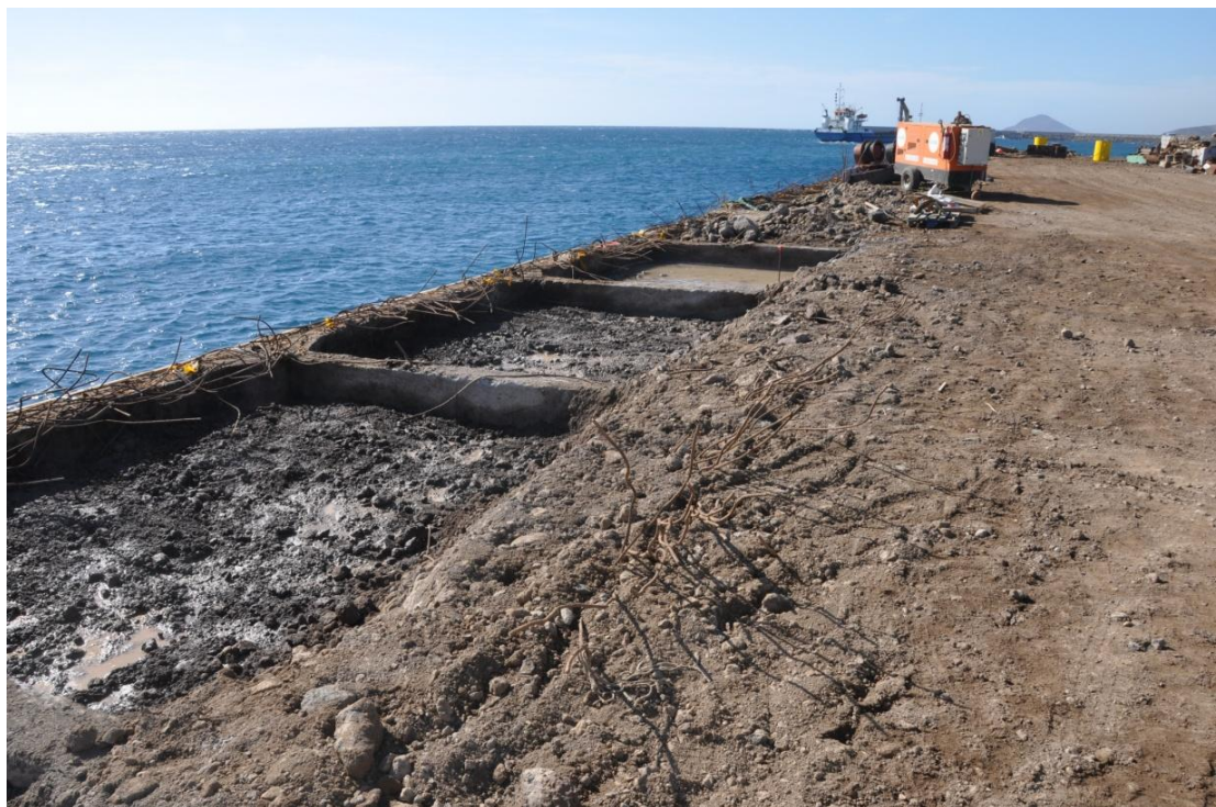
Figura 7. Cajones del muelle de ribera (20 nov. 2015)
