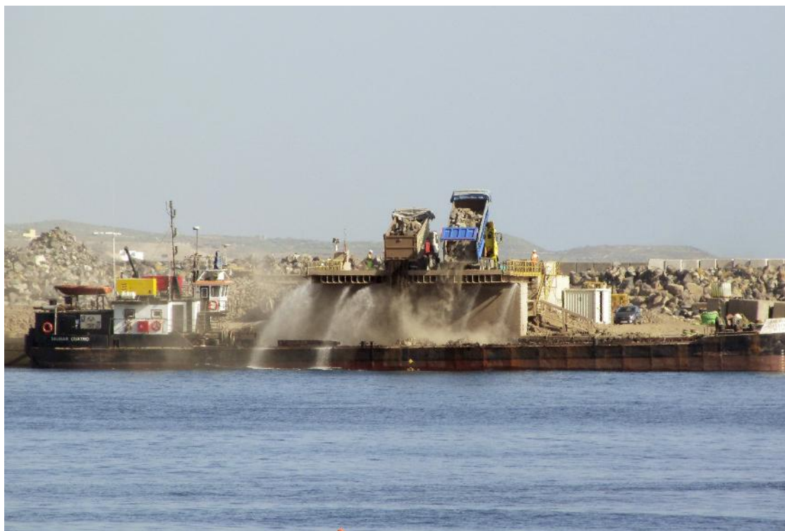
Figura 36. Lavado de materiales sobre el gánguil en el momento de su descarga (Febrero 2015).
