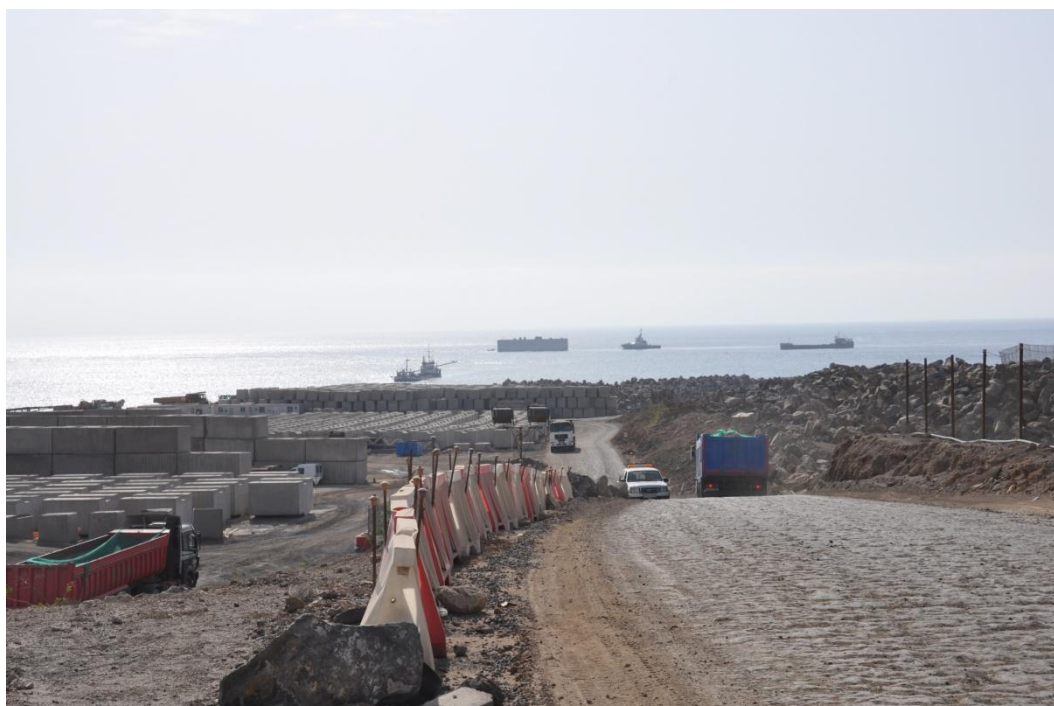
Figura 10. Aspecto de la obra y (al fondo) traslado de uno de los cajones (2 octubre 2015)
