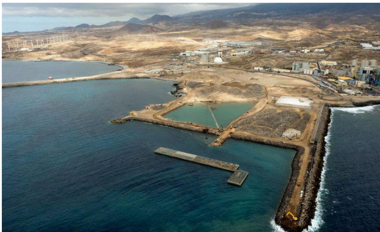
Figura 12. Panorámica de los avances en el muelle de ribera (junio 2015) Foto: Puertos de Tenerife
