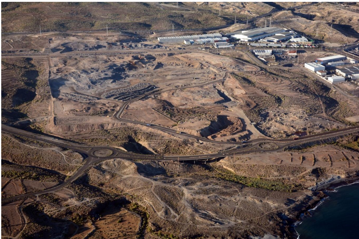
Figura 34. Zona de extracciones en el polígono industrial de Granadilla vista desde el Sur.
