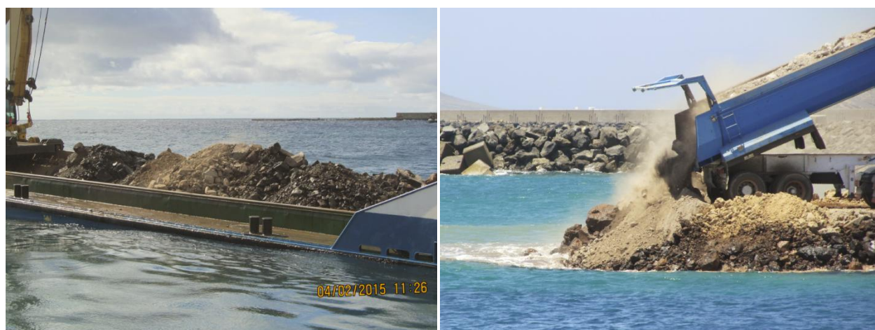
Figura 35. Control visual de la calidad del material sobre el gánguil (febrero 2015) o en el momento de descarga de los camiones (mayo 2015).
