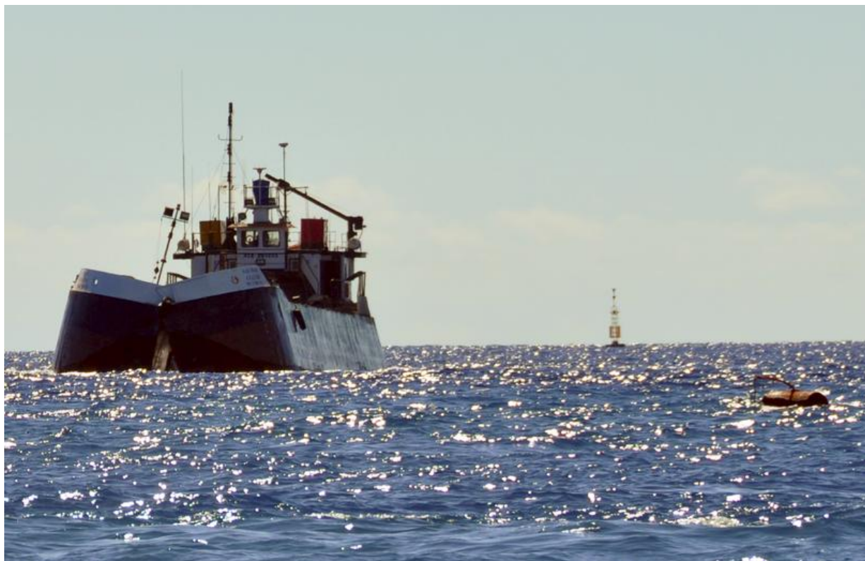
Figura 37. Momento de la descarga del gánguil para formar las banquetas (Febrero 2015).
