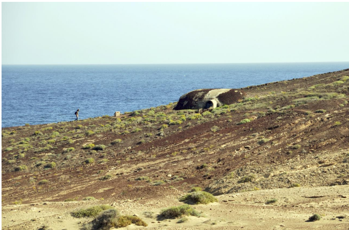
Figura 26. El bunker de Montaña Roja, destinado a convertirse en caseta de observación de aves, sigue pendiente de las mejoras orientadas al uso público.
