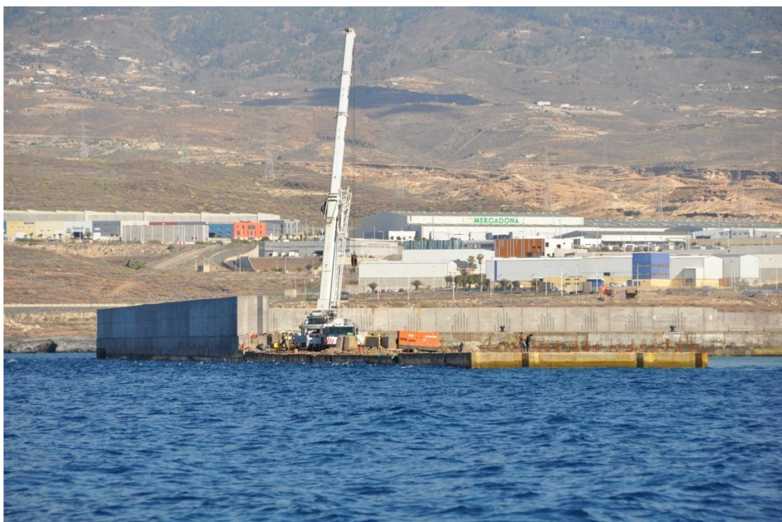
Figura 8. Rellenado de los cajones del martillo del contradique (15 abril 2014)
