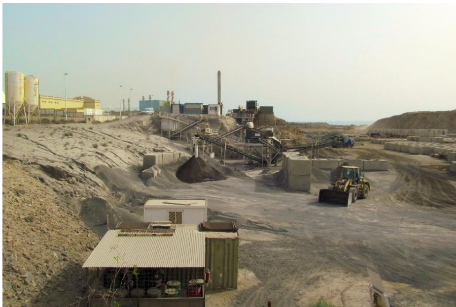
Figura 39. La planta machaca- dora es la principal fuente generadora de polvo en la obra y ha de aplicar medidas reductoras del polvo de modo permanente.
