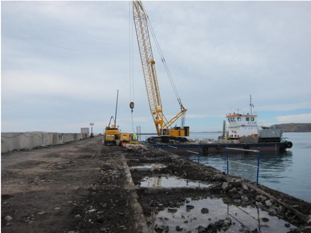
**Figura 6. Rellenado de los cajones del dique exterior (29 diciembre 2016)**
