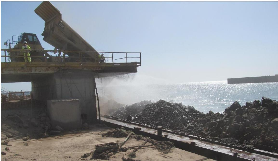
Figura 30. Control visual de la calidad del material sobre el gánguil (25 enero 2016) y verificación de que se produce el lavado con aspersores.
