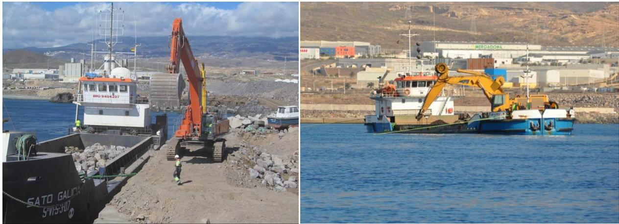
Figura 31. Colocación del material mediante retroexcavadora en tierra y en el mar (agosto 2016).
