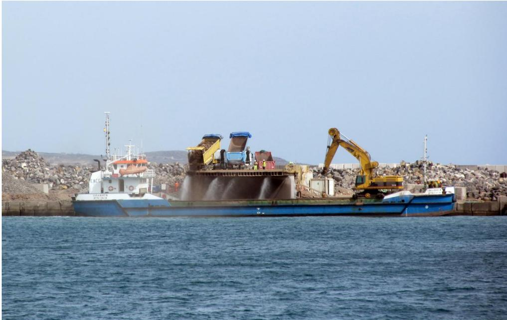
**Figura 32. Lavado de materiales sobre el gánguil en el momento de su descarga (Febrero 2016).**
