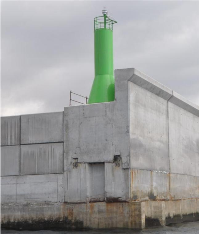
**Figura 32. Marca de estribor en el martillo de la obra de abrigo (bocana de entrada al puerto)**
