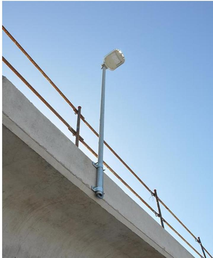
**Figura 19. Luminaria provisional instalada en la cara interna del espaldón de la primera alineación**
