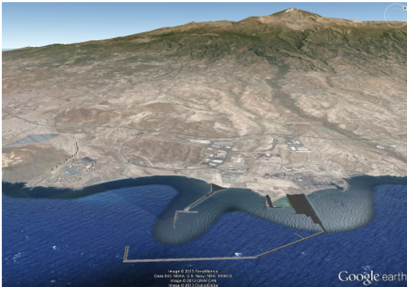
Obras de abrigo del puerto de Granadilla finalizadas en 2017
